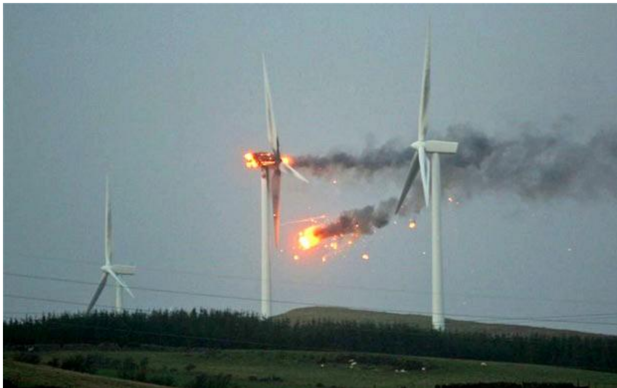
Rys. 12. Pożar turbiny wiatrowej [9].
