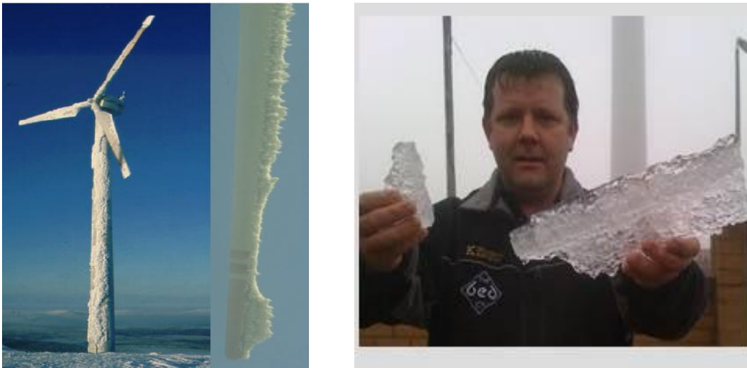
Rys. 1. Oblodzenie turbiny i fragmenty odrzuconego lodu [2],[9].
